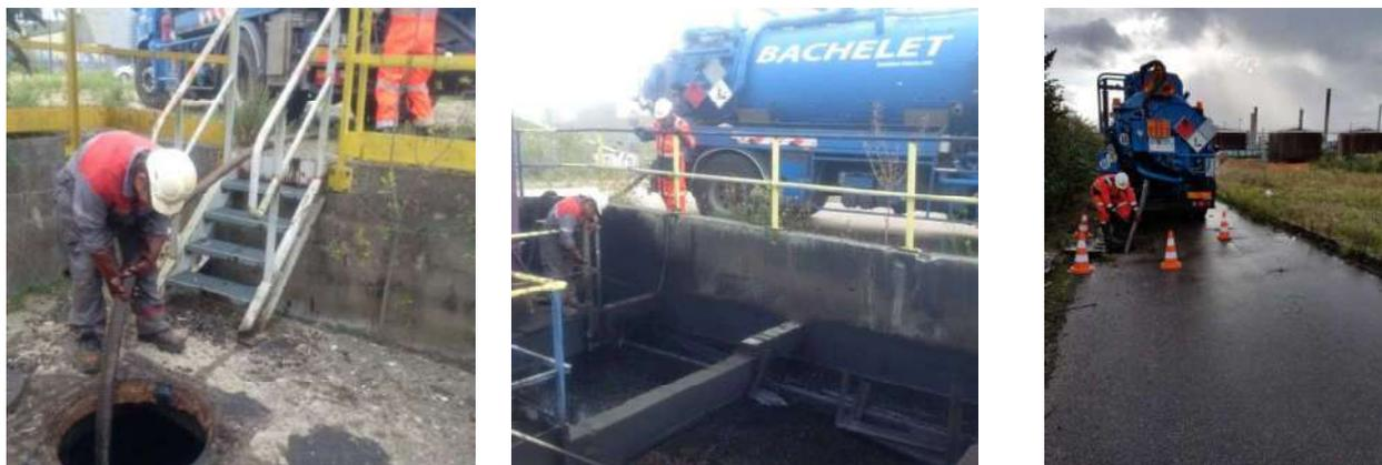
Figure 55 : photographies des opérations de pompage et de nettoyage des réseaux d'égouts de la raffinerie et des API
